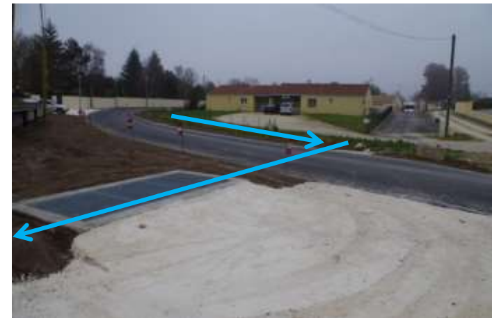
Pont crée sous la RD44, Arrivée du pluvial mis en souterrain, Chambre de visite situé entre les 2 ponts
