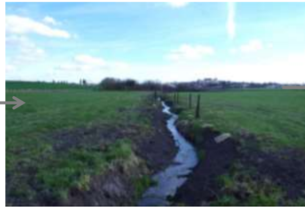
Reprise de berges, mise en place de sinuosités et de plants
